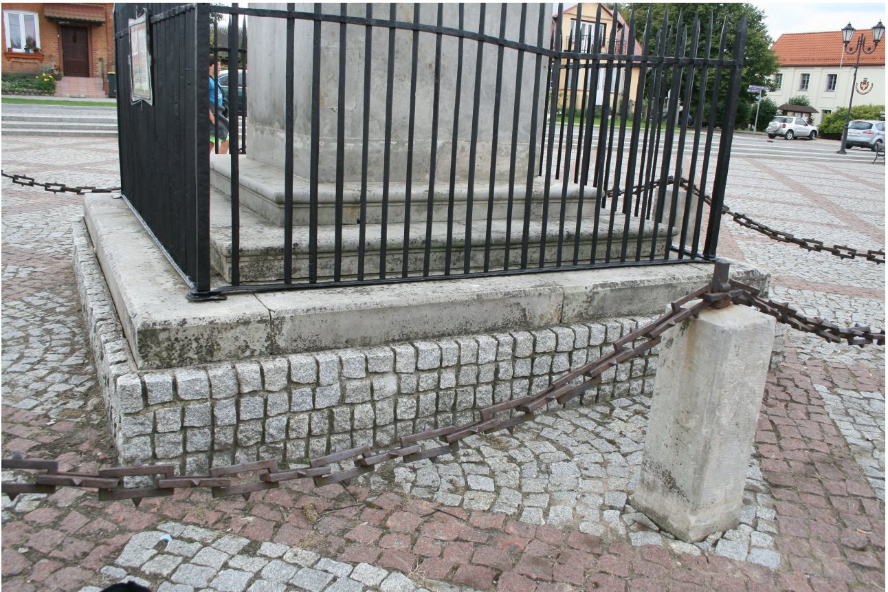
FOT. 15 TYKOCIN. POMNIK STEFANA CZARNIECKIEGO. DOLNA CZĘŚĆ POMNIKA -PODSTAWA COKOŁU, STOPNIE I OGRODZENIE. ZDJ. WYK 18.08.2016
